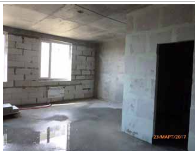
Внутренне состояние домов
